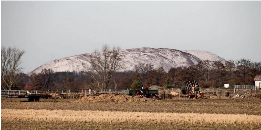
Der Wathlinger Kaliberg – hier der Blick aus Westen – will K+S mit Bauschutt und Bodenaushub abdecken, am Ende wird seine Grundfläche doppelt so groß wie aktuell sein. Quelle: Friedrich-Wilhelm Schiller
