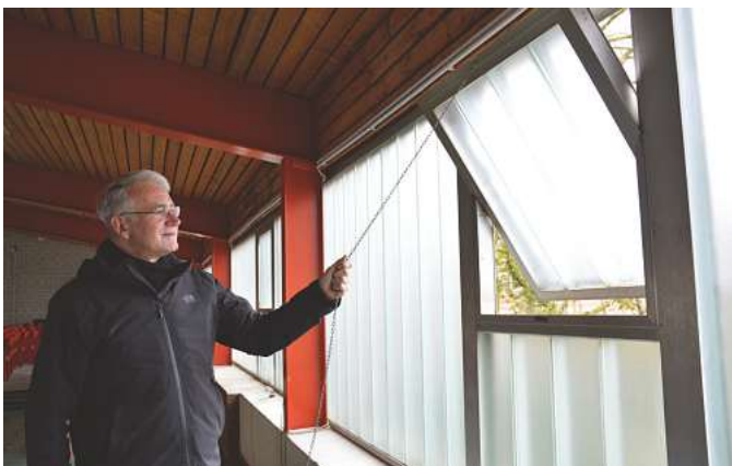
Johannes Reuter öffnet eines der alten Fenster. Sie sind undicht und lassen sich zum Teil nicht mehr richtig schließen.
