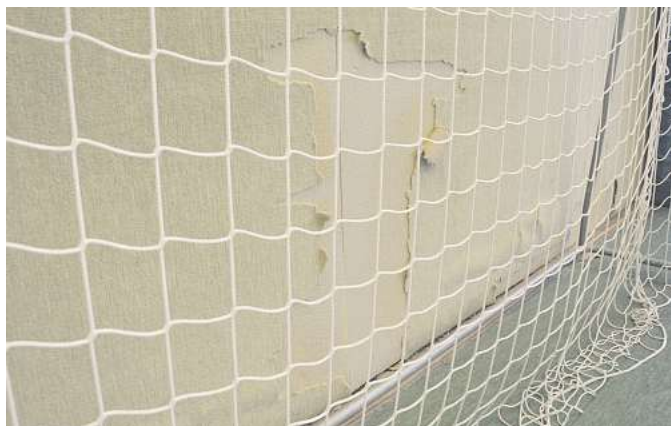
Der Prallschutz an den Wänden ist an mehreren Stellen abgerissen.
