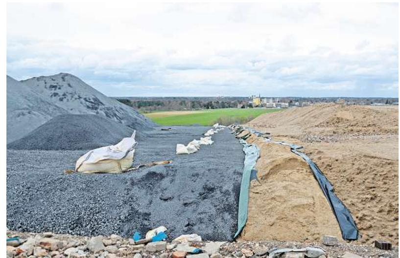
Schicht über Schicht: So wird der Deponieberg umweltsicher verpackt. Das ist nötig, damit kein Gas und Wasser entweichen.
